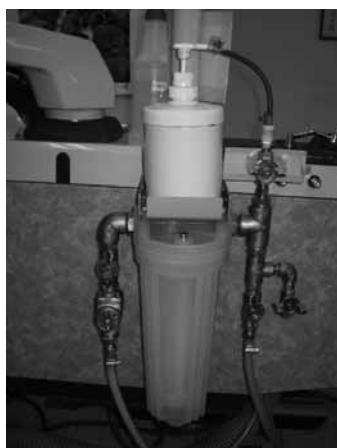
図18 歯科用ユニットに装着された水フィルター fig. 18 Water filter mounted on the dental unit
